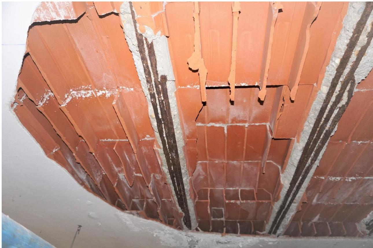
Lo sfondellamento dei solai è divenuto ormai un problema diffuso e piuttosto frequente nella tipologia di solai ad elementi in laterizio prefabbricati. Essa investe l'intradosso dei solai, causando il cedimento per rottura e distacco di fondelli interni delle pignatte e/o di travetti in latero-cemento.
