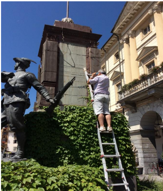
Foto 11 , 10 Luglio 2015, Aut. S. B., Lato Est. Fase di ispezione con sonda endoscopica attraverso un giunto aperto.
